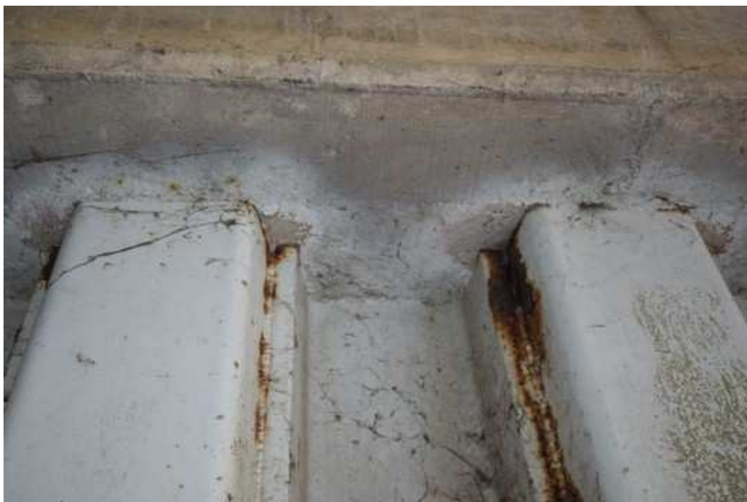
34 – Détail de la liaison palplanches /chevêtre
