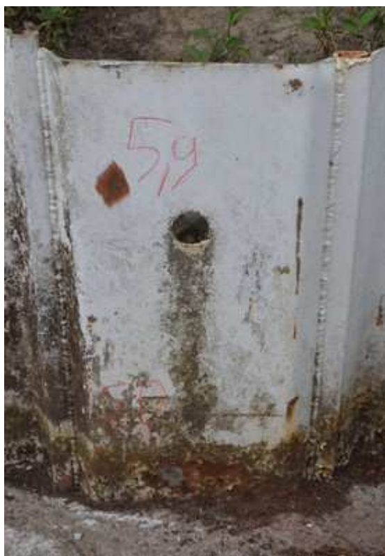
18 – Détail de la mesure d'épaisseur sur une âme saine sur une palplanche d'extrémité
