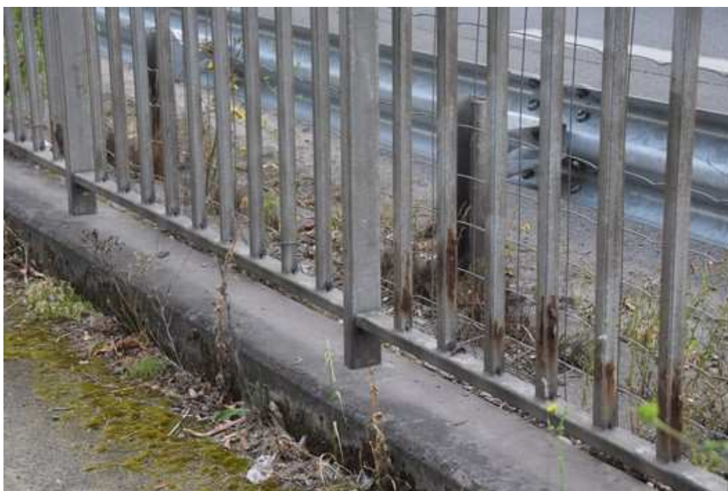
75 – Détail de la perforation de certains barreaux des garde-corps de la piste cyclable
