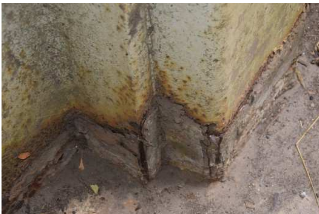
06 – Détail de la corrosion feuilletée sur une aile au pied d'une palplanche
