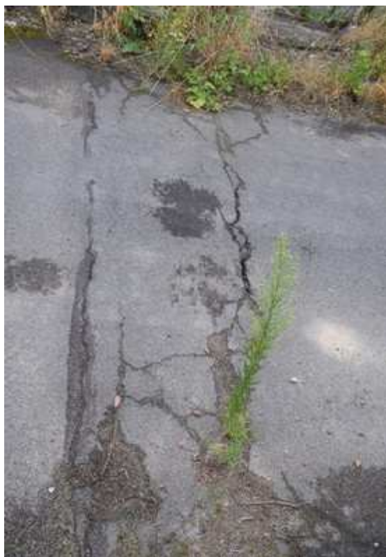
76 – Zone de fissuration au droit du piédroit côté Lille
