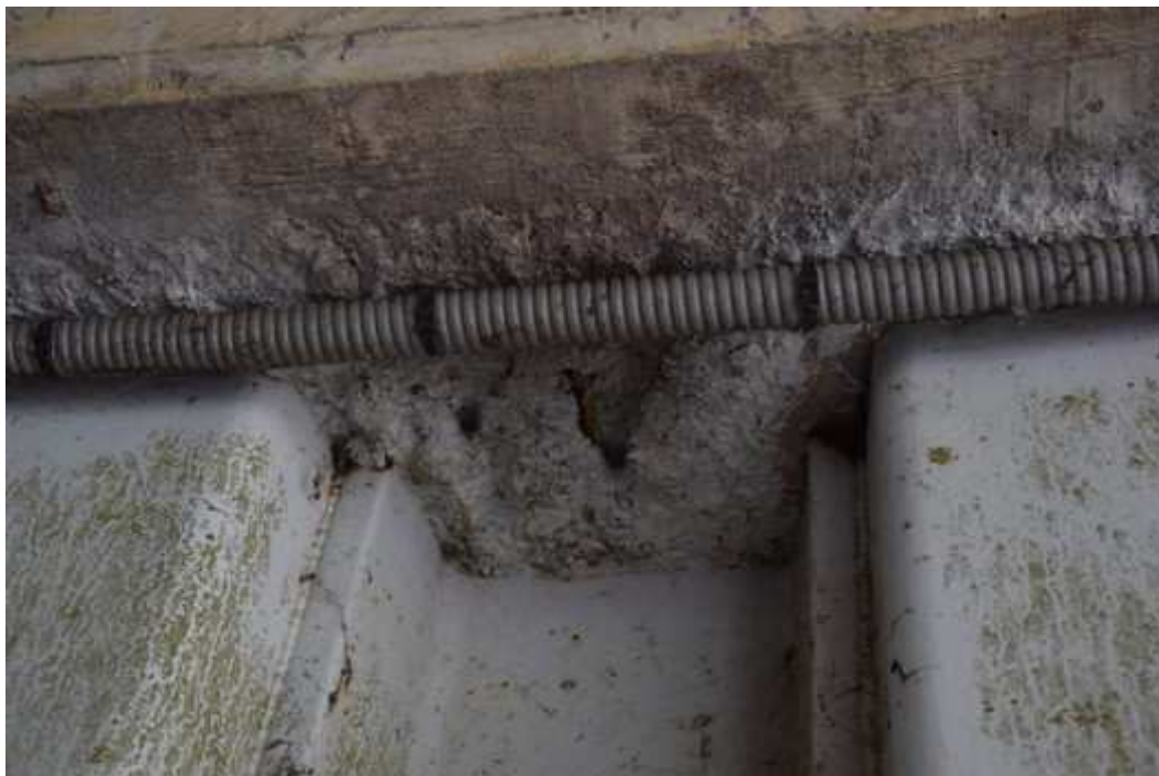
14 – Détail en sous face du chevêtre, béton grossier avec acier corrodé apparent
