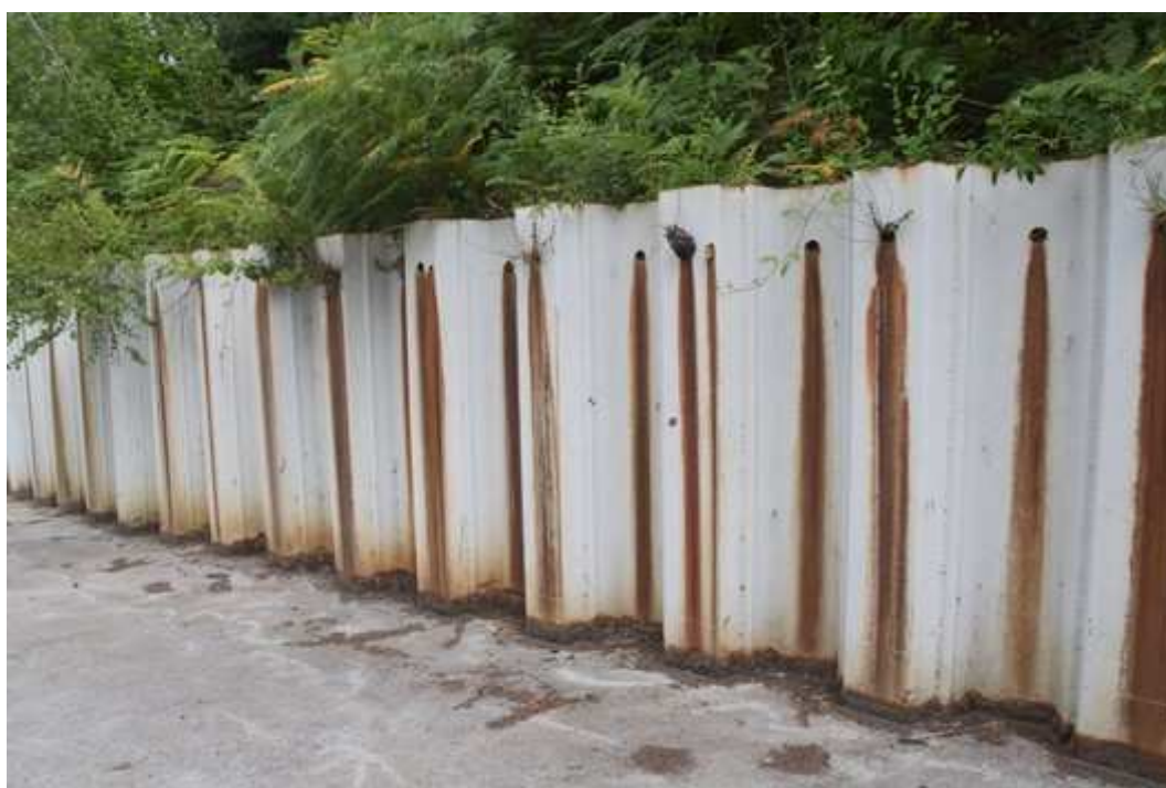
46 – Vue générale des coulures de corrosion à partir des orifices supérieures
