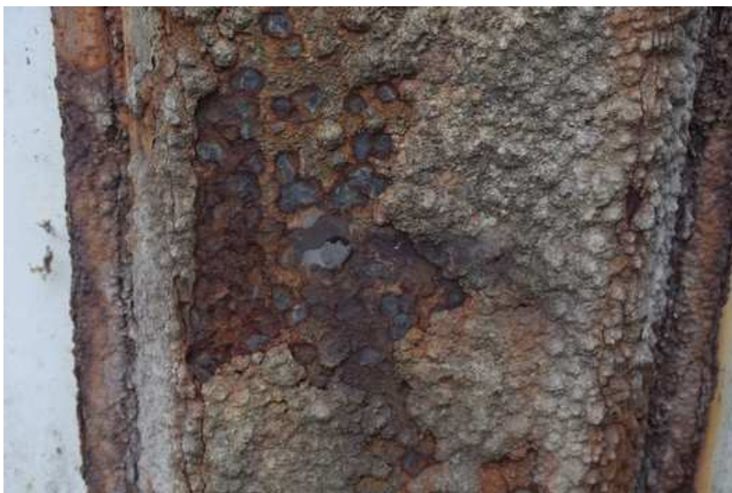
44 – Détail de la corrosion par pustule sur l'âme de palplanche
