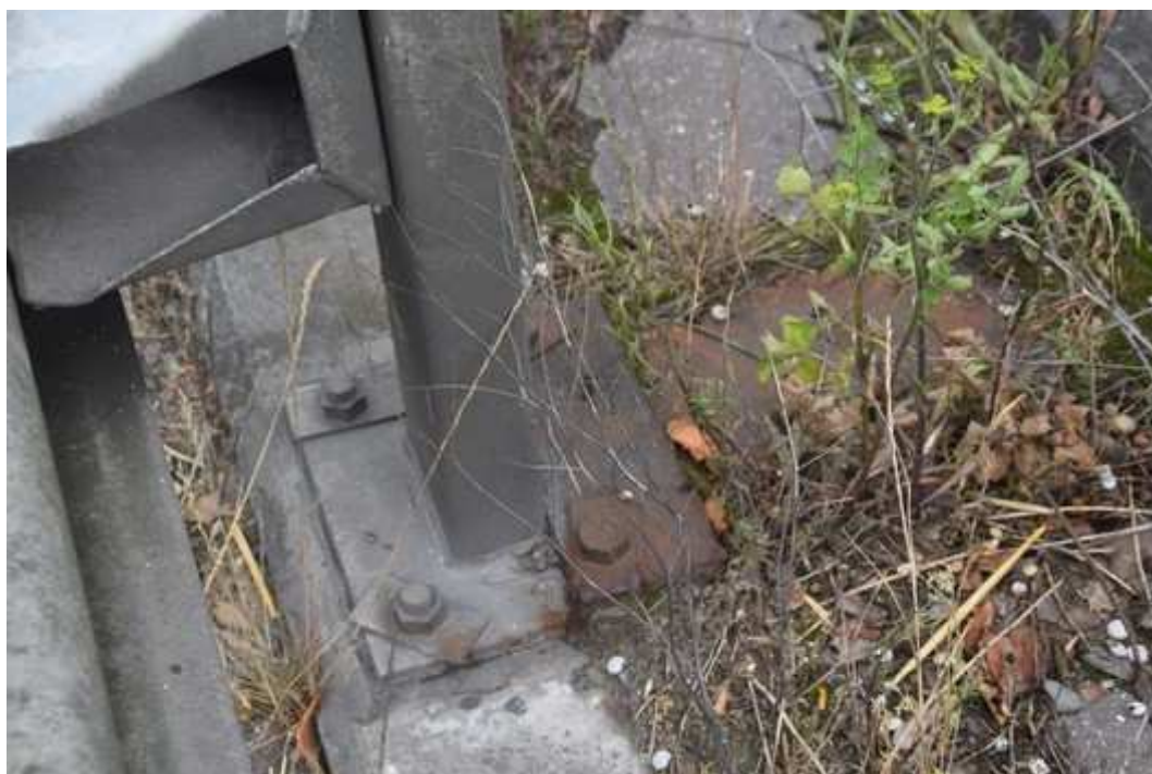
57 – Détail d'une platine de montant de glissière de sécurité côté piste cyclable
