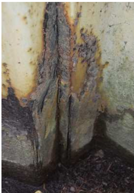
31 – Détail de la corrosion feuilletée sur une aile au pied d'une palplanche
