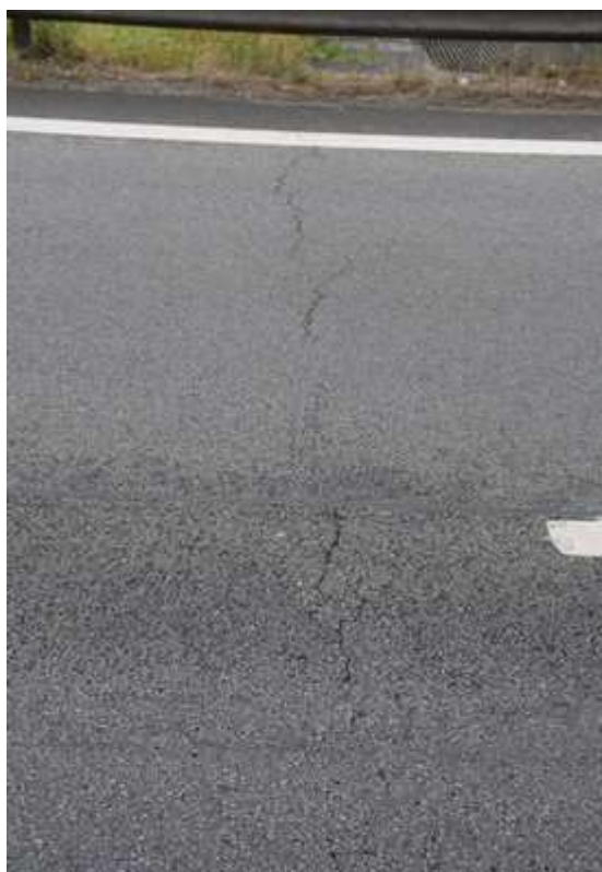
53 – Zone de fissuration au droit du piédroit côté Valenciennes
