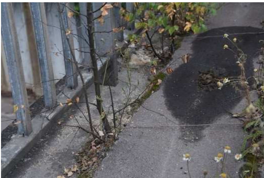
66 – Déformation de l'enrobé avec la végétation arbustive élévation côté Wallers
