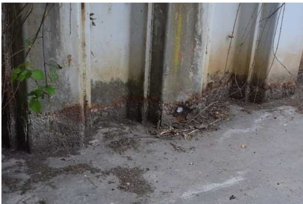
48 – Détail de la corrosion feuilletée aux pieds des palplanches à proximité du piédroit
