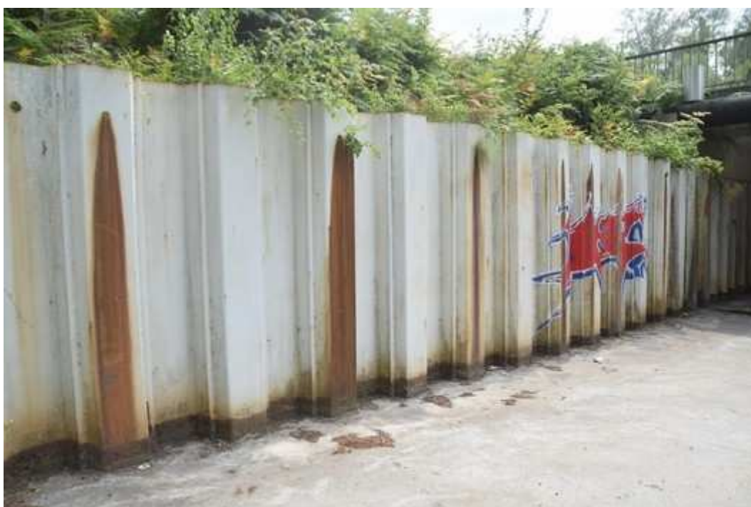
22 – Détail des coulures d'oxyde sortant des orifices supérieures
