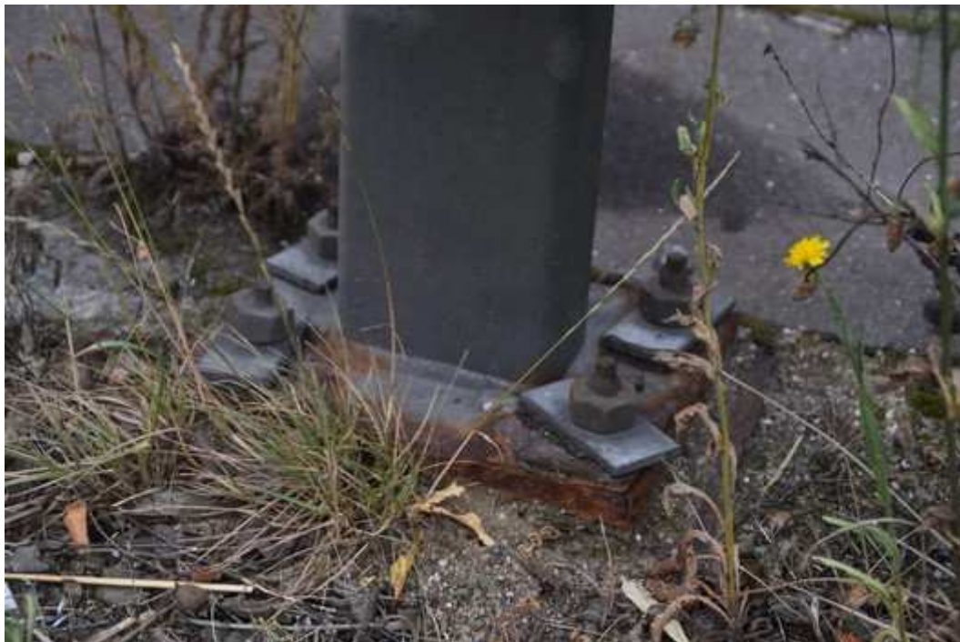
67 – Détail d'une platine de montant de glissière de sécurité corrodée côté piste cyclable
