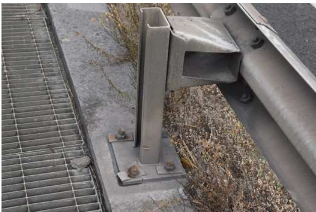
60 – Détail de la platine de fixation d'un montant de glissière de sécurité
