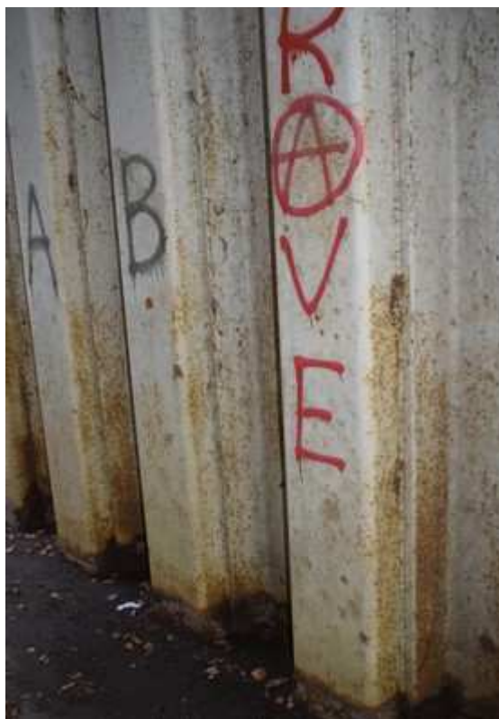
33 – Vue générale de la corrosion par piqûres généralisée
