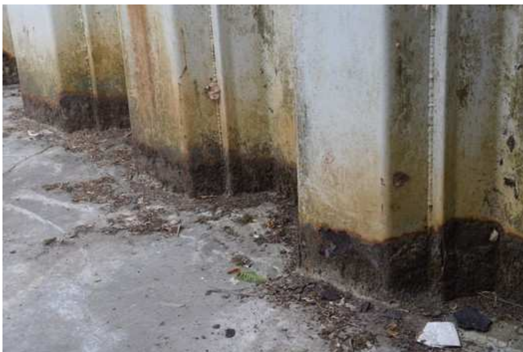
21 – Vue générale de la corrosion feuilletée aux pieds des palplanches
