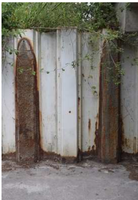
42 – Détail de la corrosion par pustules à partir de coulures d'humidité provenant des orifices supérieurs des palplanches
