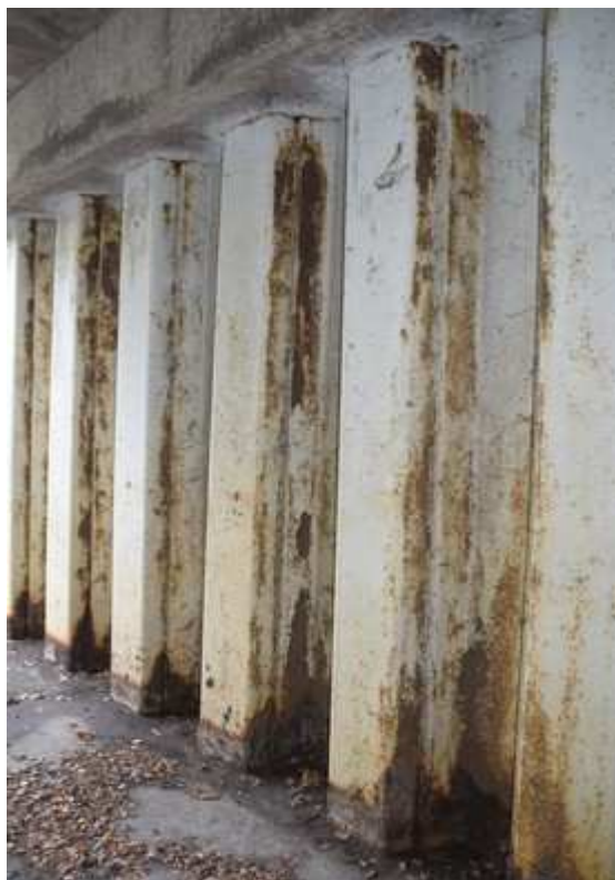
37 – Vue générale de la corrosion par piqûres des palplanches
