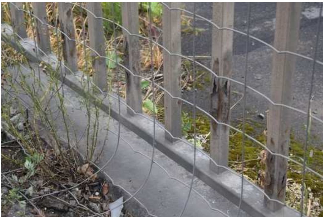
58 – Détail de la perforation du barreaudage du garde-corps côté piste cyclable
