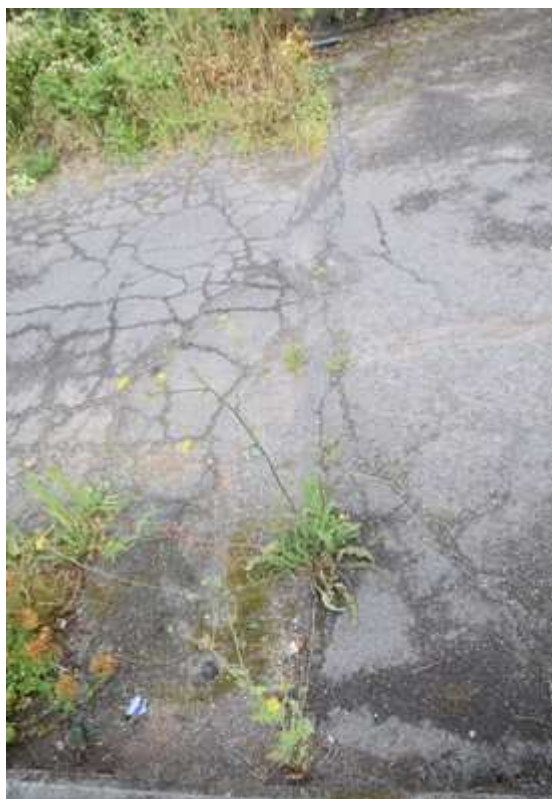
69 – Zone de fissuration au droit du piédroit côté Valenciennes
