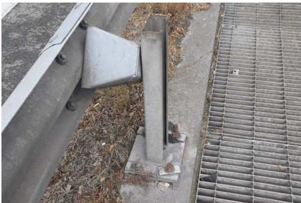
61 – Détail d'un sabot mal positionné sur une glissière de sécurité entre montant/glissière
