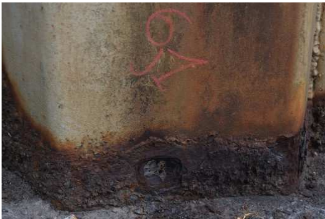
24 – Détail d'une mesure en zone fortement corrodée sur une âme en pied de palplanche
