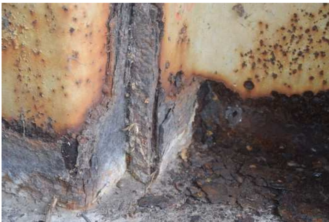
11 – Détail d'une mesure d'épaisseur dans une zone fortement corrodée sur l'âme d'une palplanche en pied
