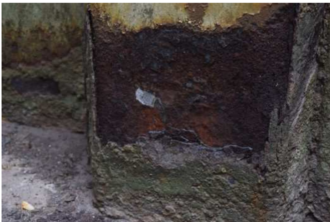
05 – Détail de la corrosion feuilletée sur une âme au pied d'une palplanche
