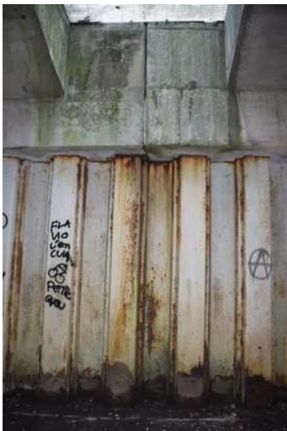
29 – Liaison entre les piédroits Lille St Amand les Eaux/Wallers Importante corrosion des tôles de jonction
