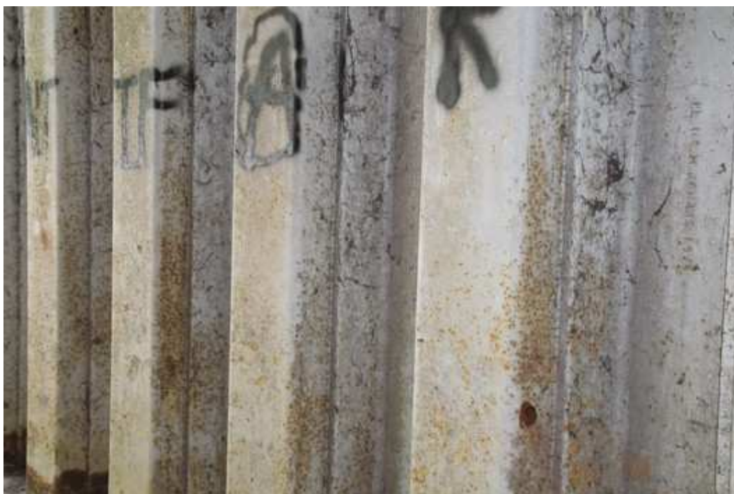
08 – Vue générale de la corrosion par piqûres généralisée
