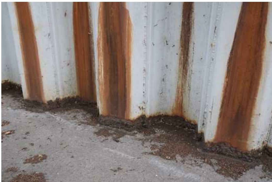
47 – détail de la corrosion feuilletée aux pieds de palplanches
