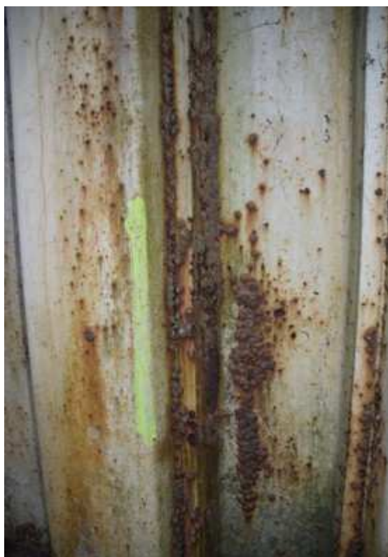
30 – Détail des pustules de corrosion à la jonction de deux palplanches
