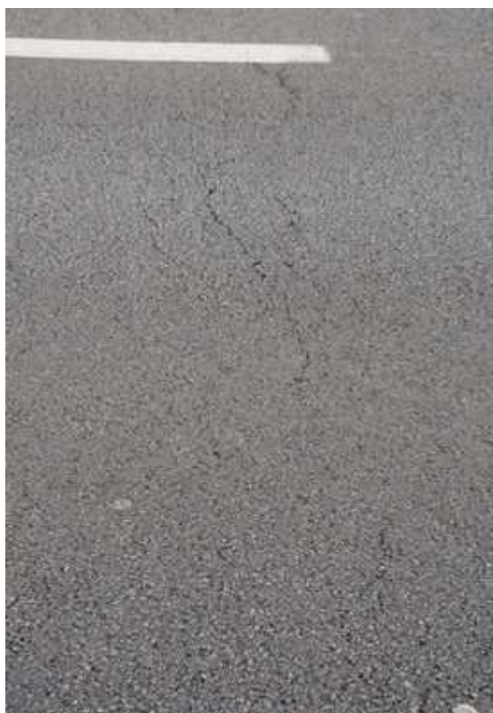
63 – Zone de fissuration au droit du piédroit côté Valenciennes
