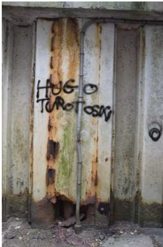
04 – Liaison entre les piédroits Valenciennes Wallers/St Amand les Eaux Perforation des tôles de jonction
