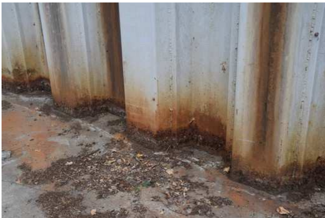
41 – Détail d'une zone de corrosion au pied d'une palplanche
