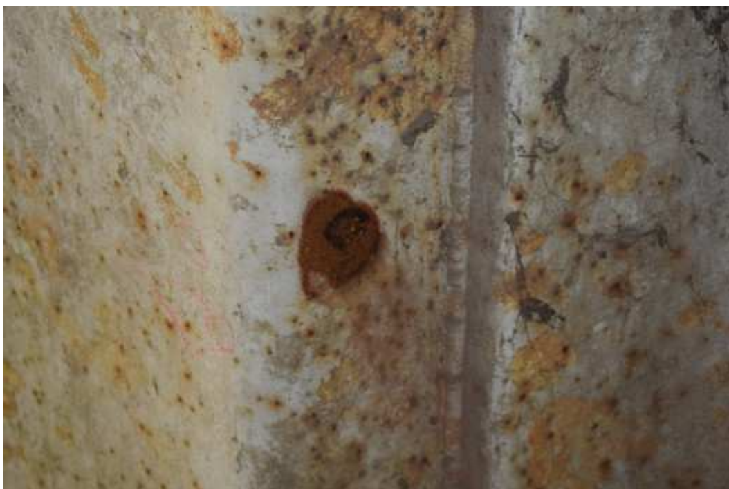
07 – Détail d'une mesure d'épaisseur dans une zone saine sur une aile de palplanche
