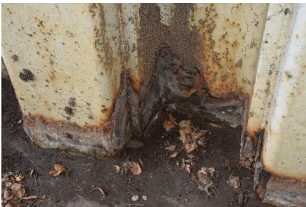
38 – Détail d'une zone fortement corrodée
