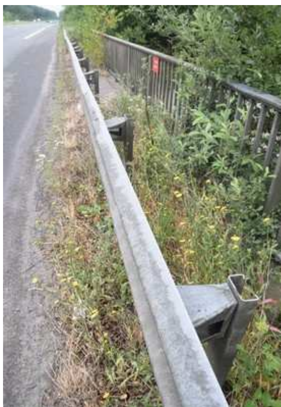
65 – Vue générale de la végétation arbustive entre la glissière de sécurité et le garde-corps élévation côté Wallers
