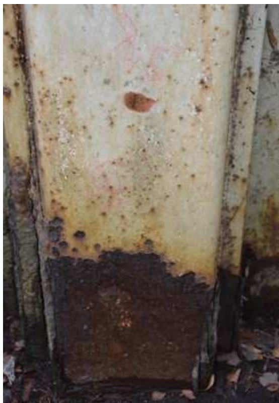
32 – Détail de mesures d'épaisseur en zone saine et corrodé sur une ame de palplanche
