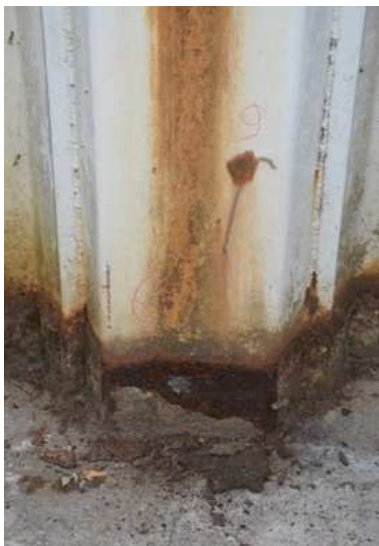
17 – Détail de la mesure d'épaisseur sur une âme fortement corrodée au pied d'une palplanche
