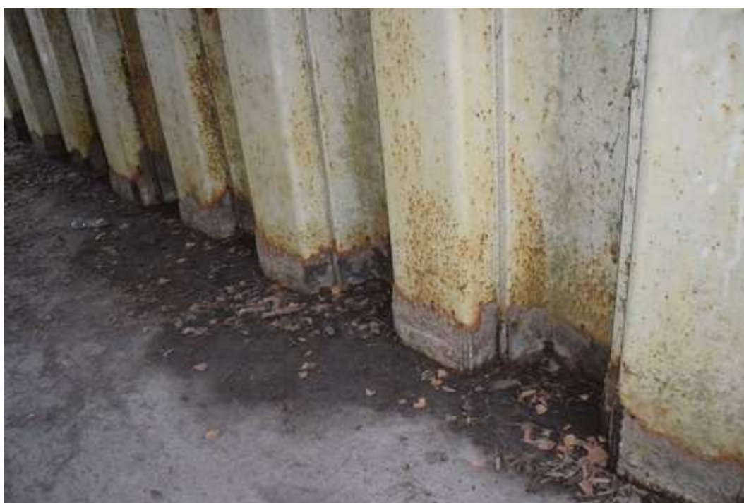
36 – Détail de la corrosion feuilletée en pieds des palplanches
