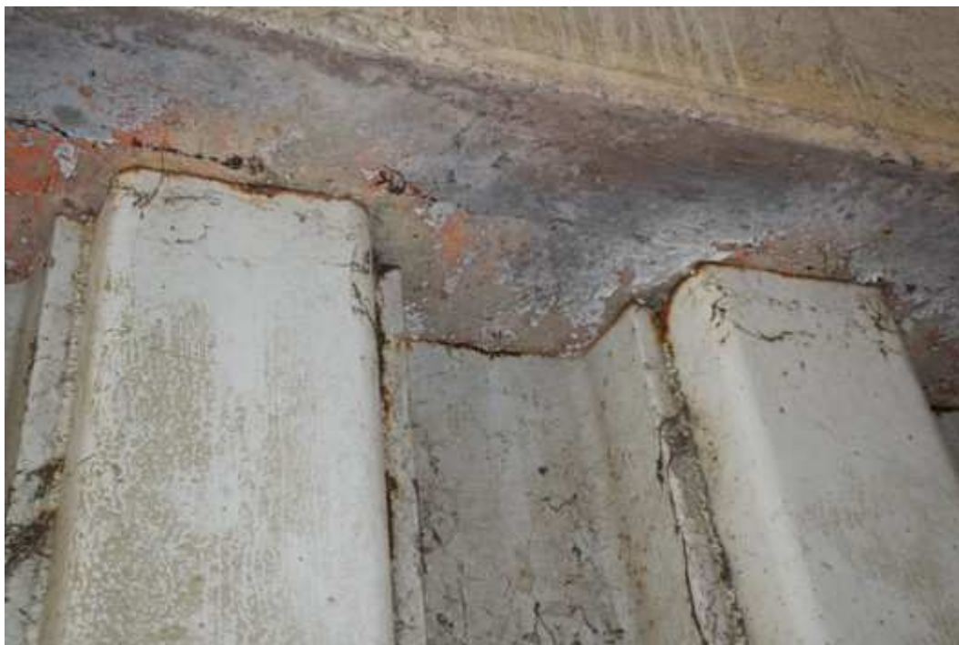
09 – Détail de la liaison palplanches /chevêtre
