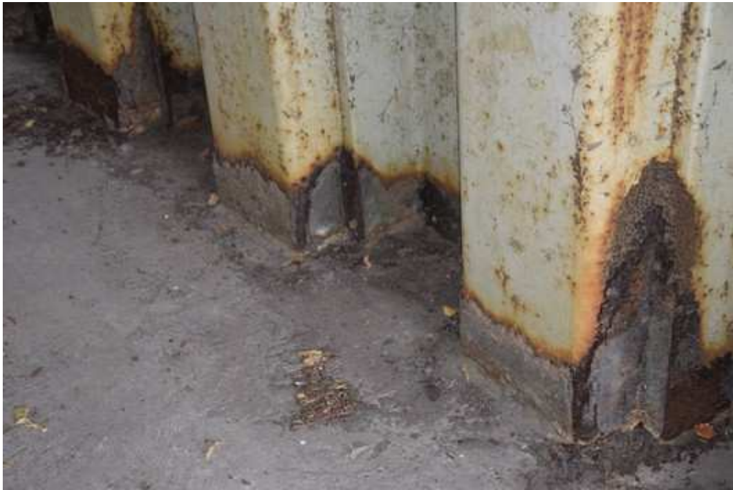
12 – Vue générale de la corrosion feuilletée aux pieds des palplanches
