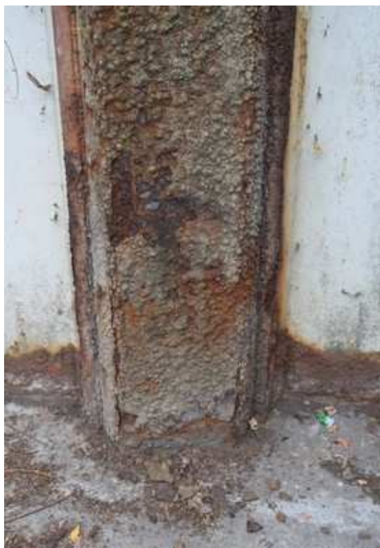
43 – Détail de la corrosion sur une palplanche
