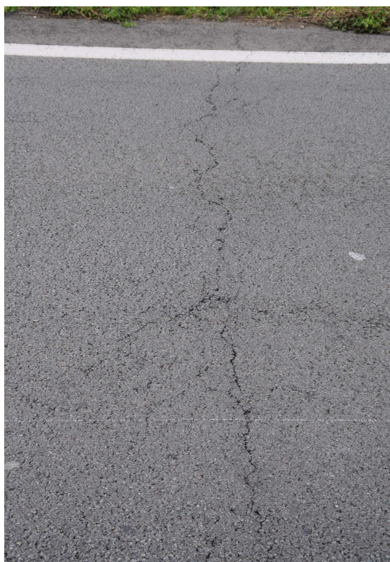
64 – Zone de fissuration à 7 m en retrait du piédroit côté Lille
