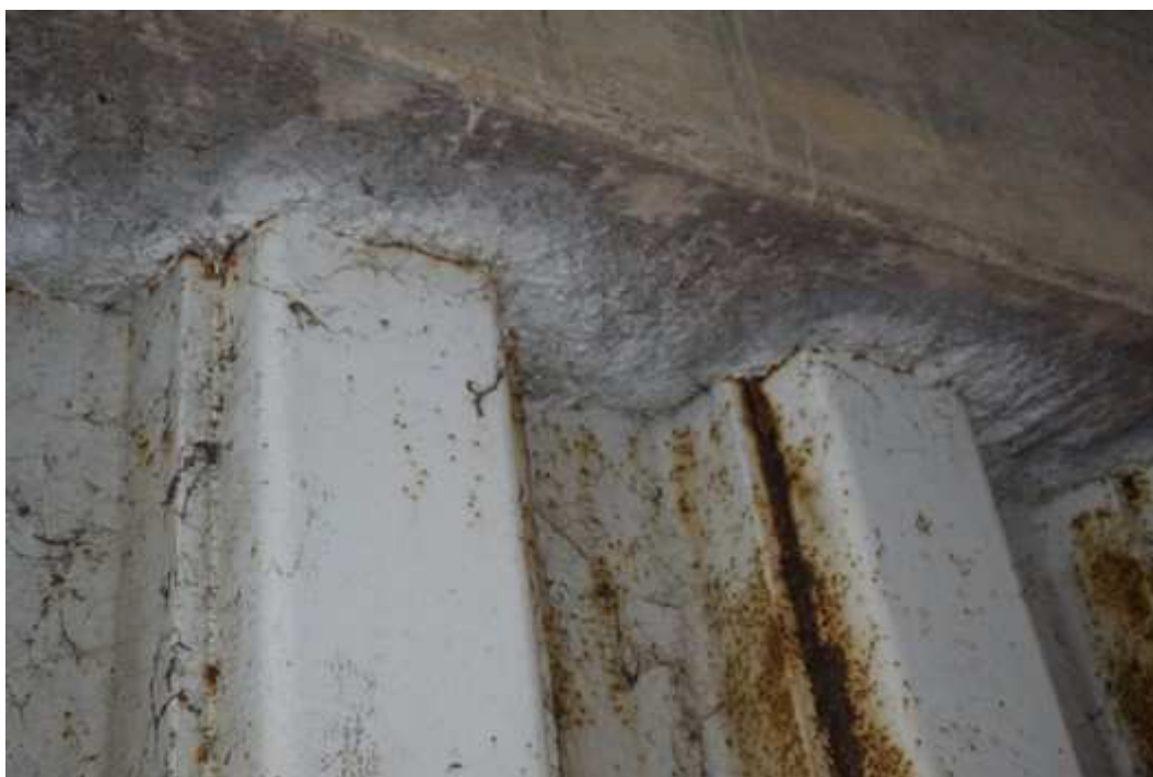
39 – Détail en sous face du chevêtre, béton grossier
