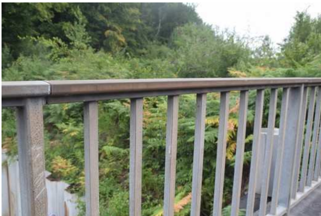
74 – Détail de la corrosion des garde-corps de la piste cyclable
