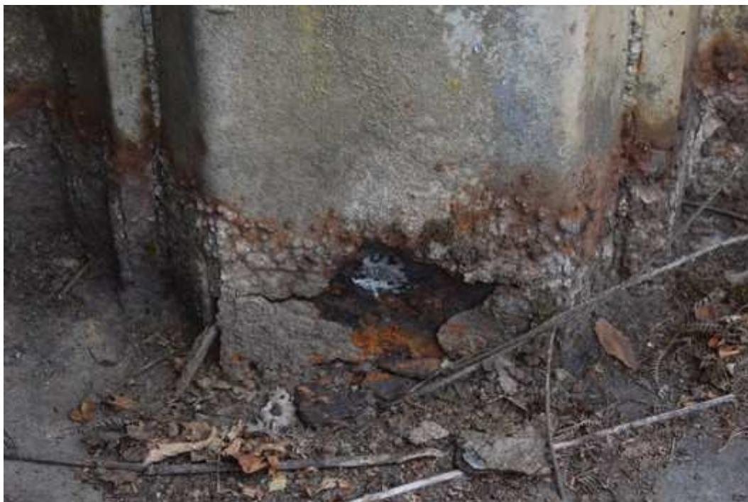
49 – Détail d'une mesure en zone fortement corrodée sur une âme en pied de palplanche
